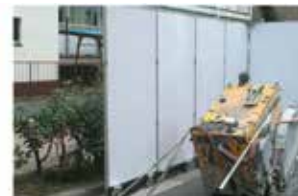
● 공사현장 이동 방음벽
