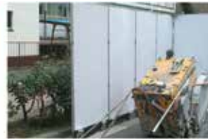
● 공사현장 이동 방음벽
