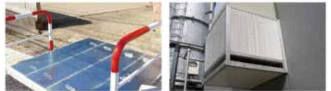
● 배수구의 수음대책, 뚜껑에 설치 ● 옥외 다트의 소음대책에 활용
