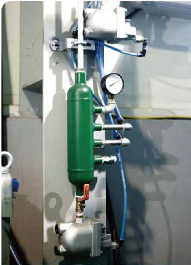
▲ 配管ラインに設置の例
