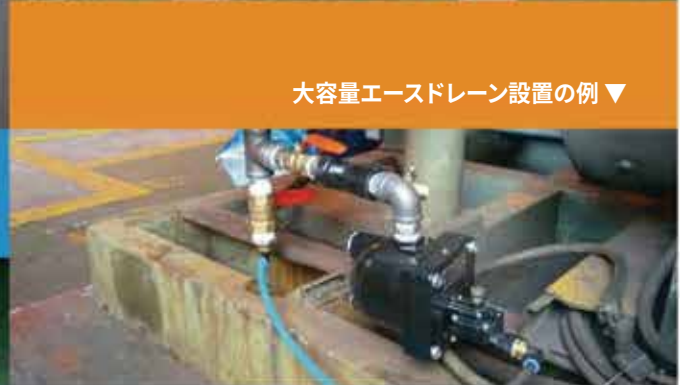
コンプレッサーに設置された例 ▼ (水平設置は上に水の流入を円滑にする為に銅圧管を連結する)
