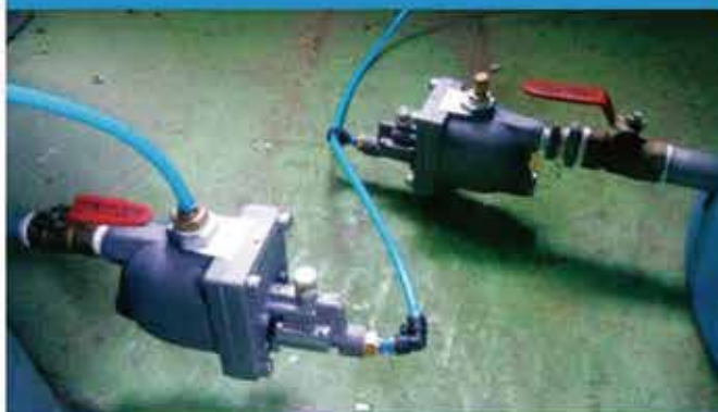
▲ 2台のレシーバータンクに銅圧管を設置した例 (事情が円満ではない場合エアベンツを付着)
