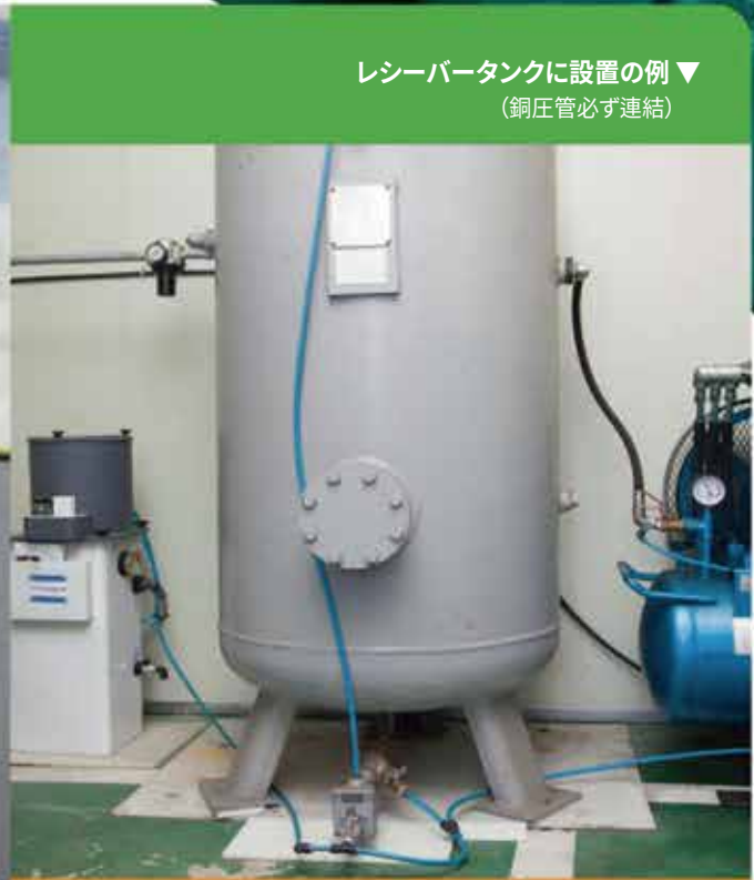
大容量エースドレーン設置の例 ▼
