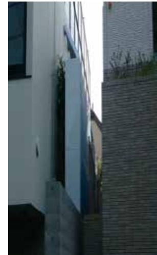
④ 돌림가능 방음벽 수치 : 8000mm×높이4000mm 용도 : 실외기 대책용 효과 : 55dB → 40dB
