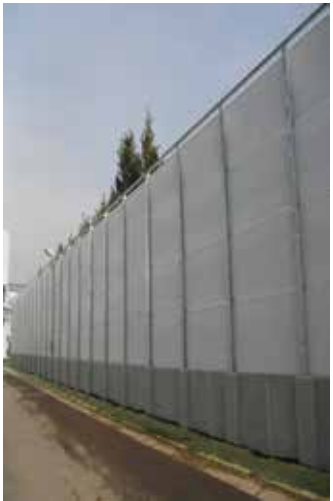
③ 공장옥외 방음벽 수치 : 2000mm×7000mm×높이4000mm 용도 : 공장의 가동음을 옥외에 전달되지 않도록 하기 위하여 사용 효과 : 90dB → 75dB
