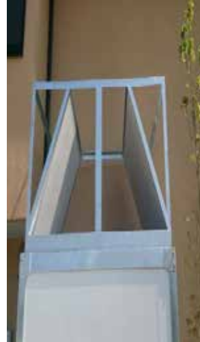
② 옥외실외기용 사이렌서 수치 : 2000mm×2000mm×높이3500mm 용도 : 옥외에 설치한 실외기의 소음대책
