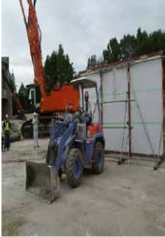
① 공사용 방음벽 수치 : 1000mm×2000mm 용도 : 공사소음 대책 효과 : 80dB → 70dB
